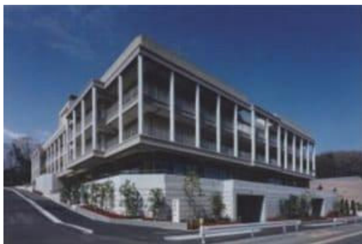
特別養護老人ホーム 芙蓉苑 外観
